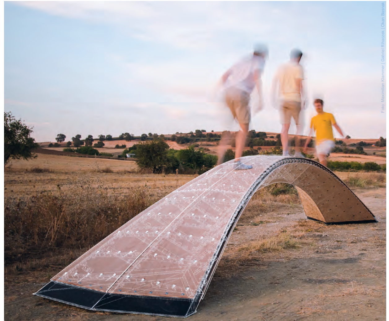
TimbRfoldR | 2020 | CNC Fräse, Akkuschauber, Oberfräse Buchensperrholz 8mm, Spanplattenschrauben, Halbrund- holz Fichte, Sicherheitsgurt 4 cm | 700 x 140 x 125 cm
